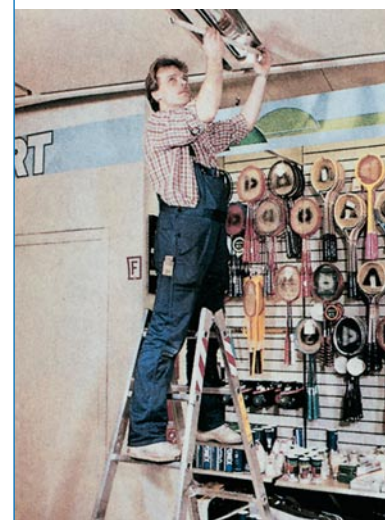
Bild: 44. Sicherer Stand bei Über-Kopf-Arbeiten
